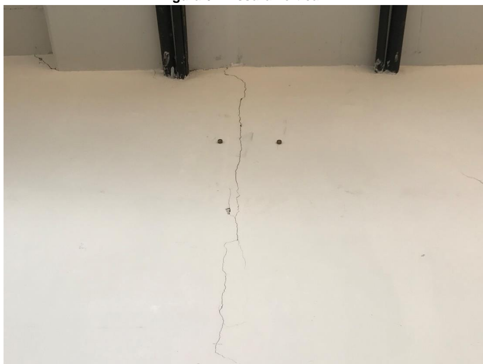
Figura 6 - Fissura vertical.
