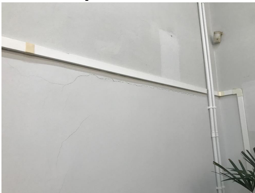
Figura 10 - Fissura interna.
