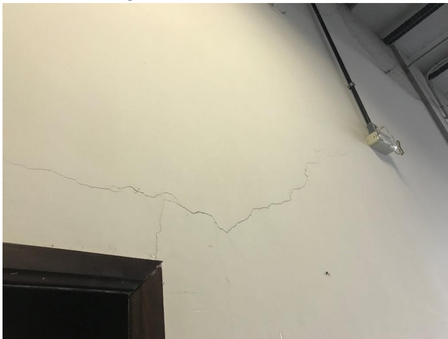
Figura 9 - Fissura no lado externo.
