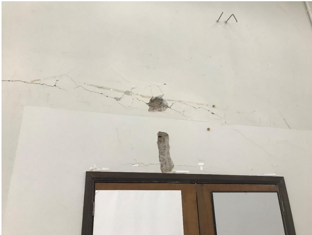
Figura 3 - Fissuras e descolamentos.
